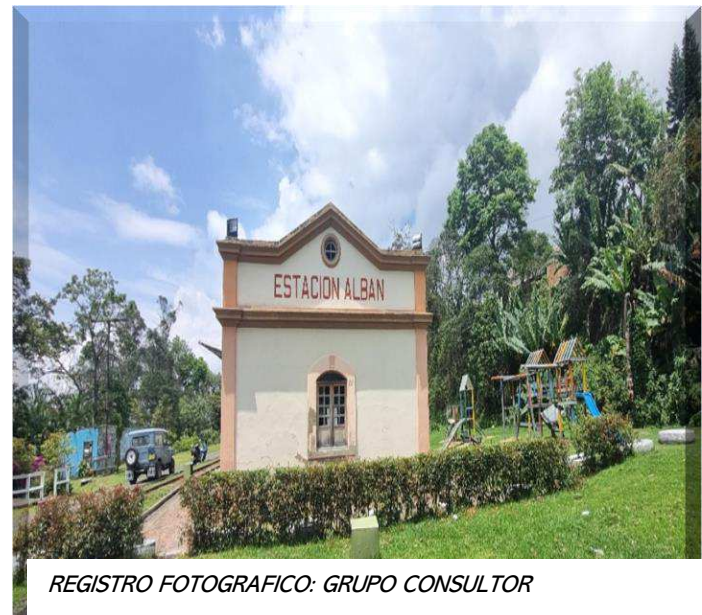
Ilustración 95. Estación del Ferrocarril Los Alpes
